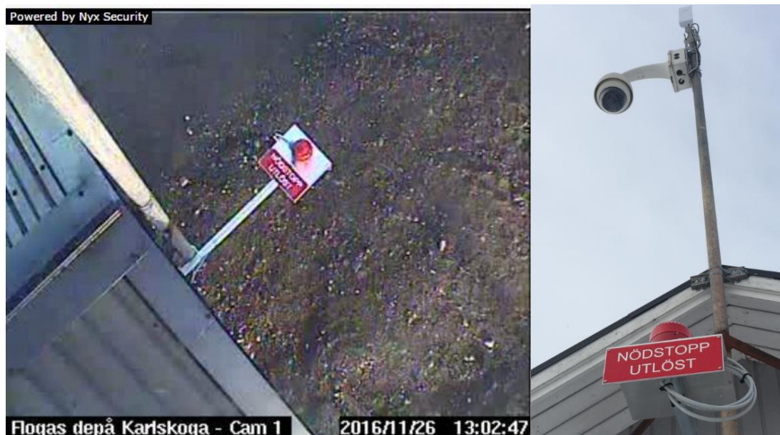
Bild ovan på ledlampan som blinkar vid utlöst nödstopp.
